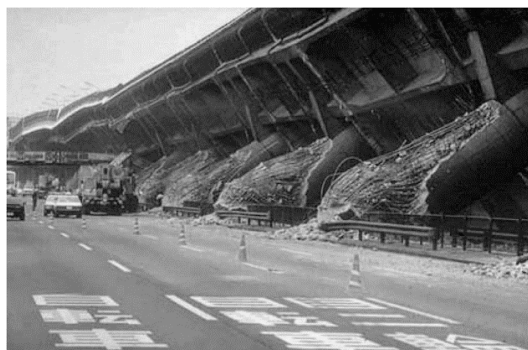
شکل ۱: ریزش پل بزرگراهی در ژاپن در اثر زلزله سال ۱۹۹۵ [۱].
