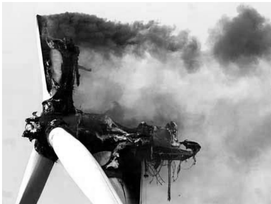
شکل ۹: شعله‌ور شدن قطعات کامپوزیتی توربین بادی در اثر صاعقه
