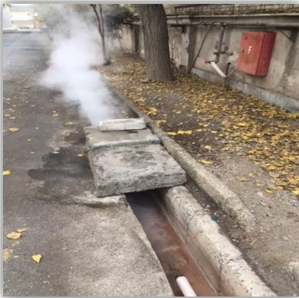
شکل ۱ خروجی بخار از مخزن کندانس
