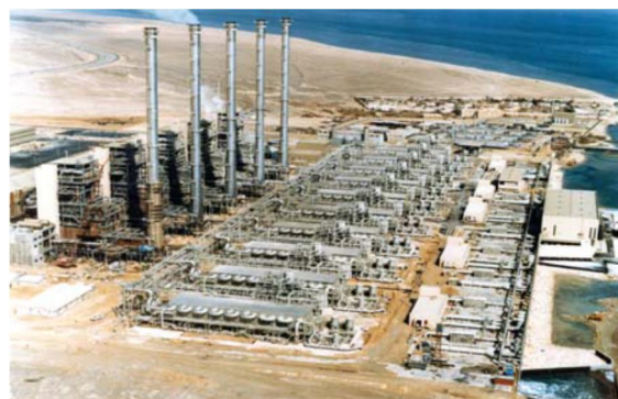
شکل ۱. یک سیستم نمک‌زدایی در مقیاس صنعتی [۳]
