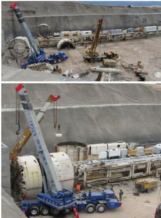
شکل ۸: مونتاژ کله حفار و سیستم پشتیبان دستگاه بازی‌دراز.
