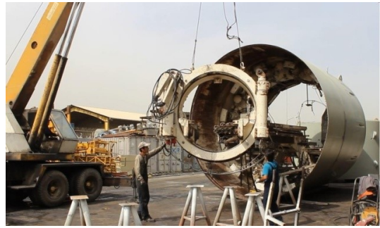
شکل ۷: پرسنل فنی در حال بازسازی دستگاه برای حفاری تونل چمشیر.
