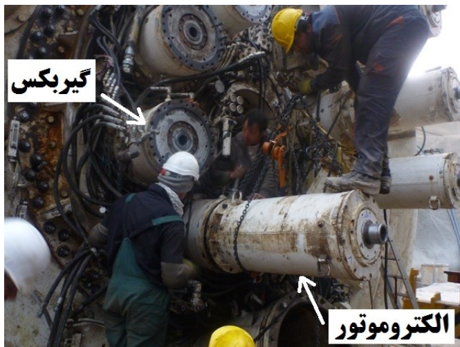
شکل ۱۴: اتصال الکتروموتورها به گیربکس‌ها (بدون مبدل).
