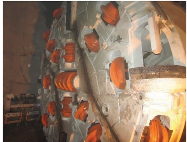
شکل ۲۰: تعویض و نصب کاترهد بر روی دستگاه در محیط تونل.
