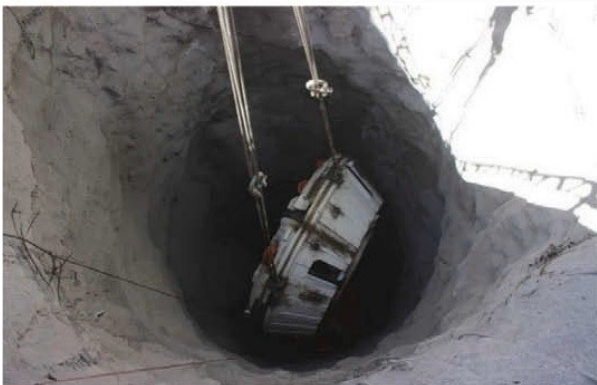
شکل ۱۹: جابجایی و انتقال کاترهد جدید از طریق شفت به تونل.
