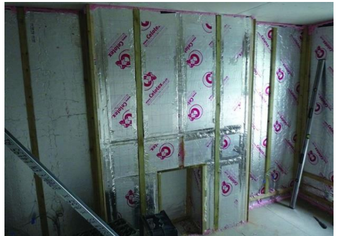
شکل ۱۲: عایق کاری حرارتی از داخل
