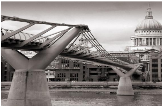
شکل ۶. نمایی از پل هزاره لندن [۷]
