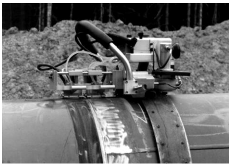
شکل ۱۲. سازوکار حلقه جوشکاری مستقر روی لوله به‌منظور بازرسی
